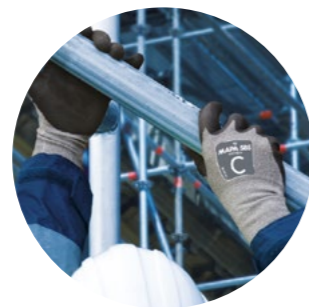
Assemblaggio di ponteggi
