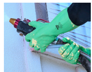
TRATTAMENTO DELLE SUPERFICI
