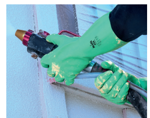
TRATTAMENTO DELLE SUPERFICI
