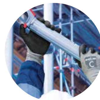
Montaggio di ponteggi
